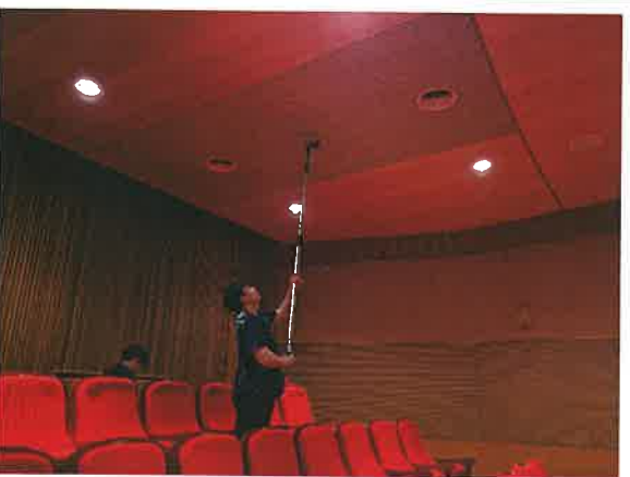
점검내용 화재감지기 동작 시험 점검장소 안산문화예술의전당 공연동
