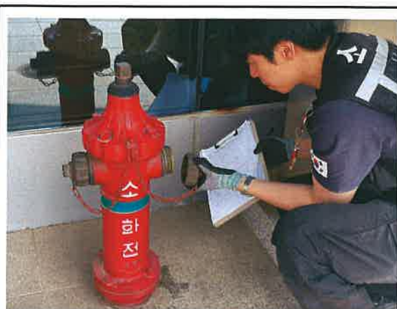
점검내용 옥외소화전설비 점검 점검장소 안산문화예술의전당 공연동
