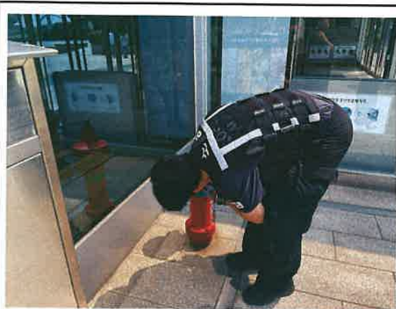
점검내용 옥외소화전설비 점검 점검장소 안산문화예술의전당 공연동
