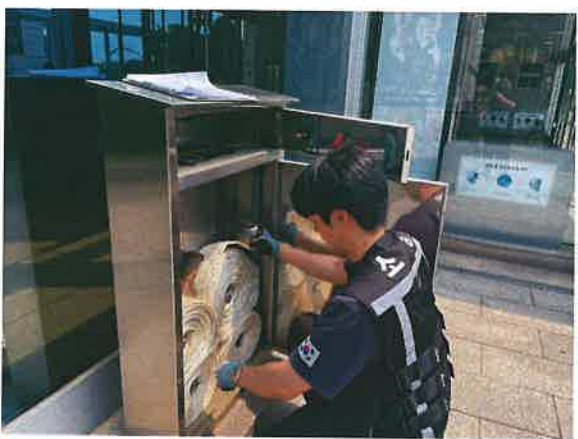
점검내용 옥외소화전함 방수기구함 점검 점검장소 안산문화예술의전당 공연동
